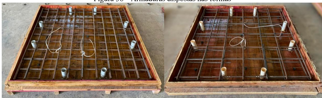
Figura 36 – Armaduras dispostas nas fôrmas
